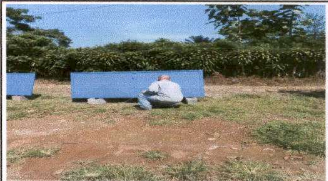
Foto 10: Fabricacion e instalacion de puertas de metal en modulos
