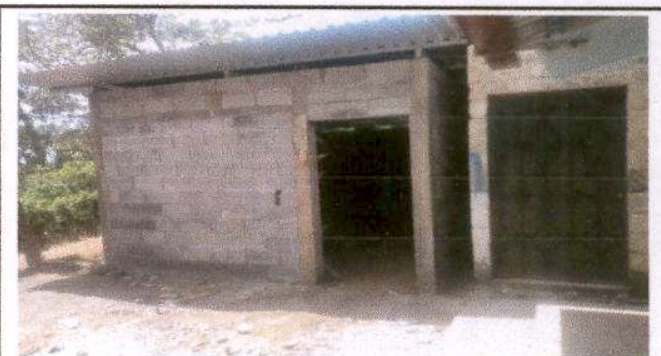
Foto 6: Reparación de muro perimetral de block
