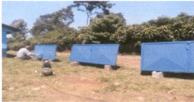
Foto 7: Fabricacion e instalacion de puertas de metal en modulos
