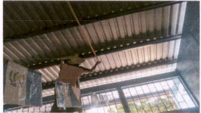
Foto 8: Desinstalacion de estructura portante
