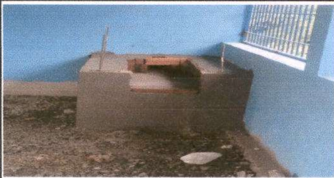
Foto 9: Sustitucion de estufa rural (completa) incluye chimena y planta de metal
