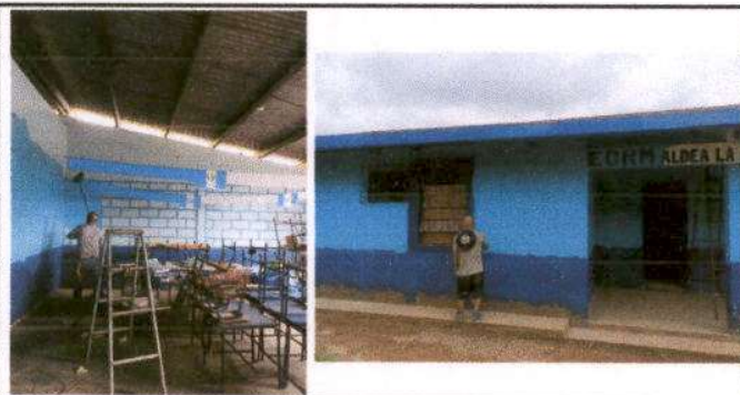
Foto 5: Pintura en muros exteriores e interiores
