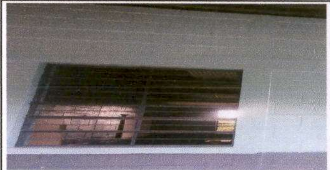
Foto 12: Sustitucion de balcon de metal
