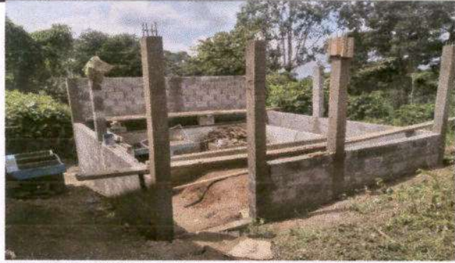
Foto 1: Mejoramiento y ampliación de la cocina de madera por metal.
