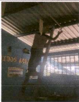
Foto 11: Desinstalacion de estructura portante
