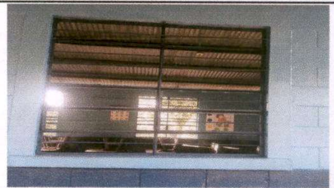
Foto 2: Sustitución de balcón de metal
