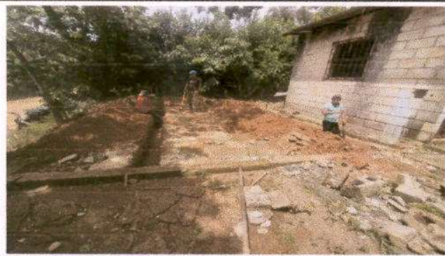
Foto 3: Reparación de piso de torta de cemento
