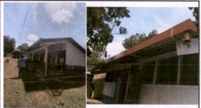
Foto 4: Sustitución de canal de metal
